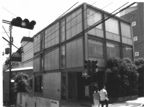
图1-14 WALL STEP的临街部分采用了钢结构
