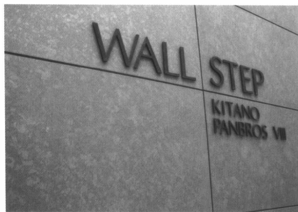
图1-15 WALL STEP外墙的镀锌铁板形成冷峻的表情
