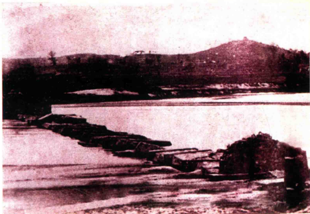
抗日时期被炸毁的滹水县南门河大桥
