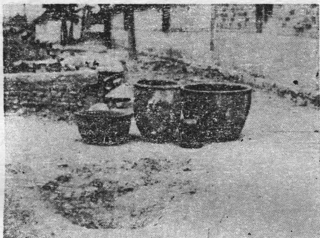
1941年山东胶东兵工五厂在牟平县卧虎村时制造硫酸用的坛子（山东机器厂史志办提供）
