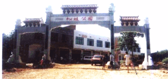
◀ 座落在大祥区雨溪镇内的“松坡公园”
