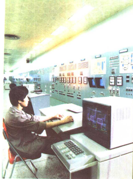
▲ 上海石油化工总厂二期工程年产1.5万吨涤纶纺丝设备投入生产，左图为聚酯装置控制室 王洪德 史云 摄
