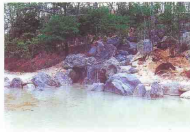
正在施工的大水池组石
