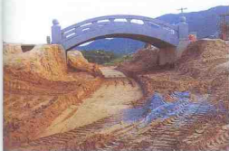
施工中的石桥和大水池
