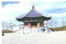
施工中的开山室
