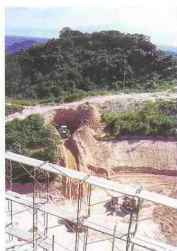
俯瞰施工中的大瀑布和水池
