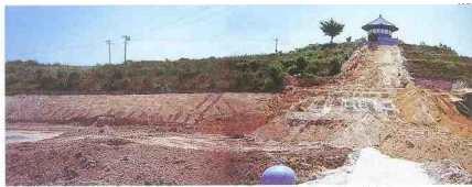
施工中的B**
