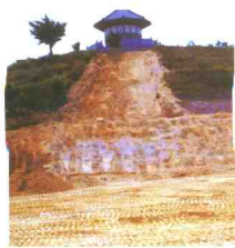
施工中的大水池和阶梯部分
