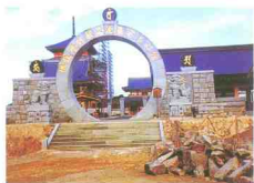
施工中的真行门**
