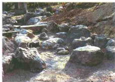
施工中的大瀑布的上游**
