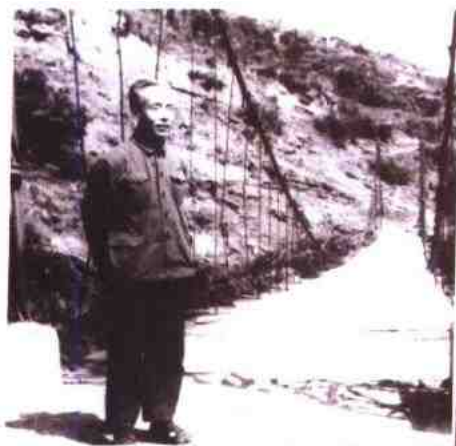
县水电局驻紫云 水库工地技术指吴文 培在他设计的铁索桥 前留影
