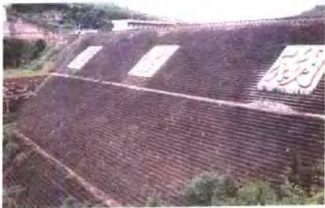
雄伟的土石混合坝
