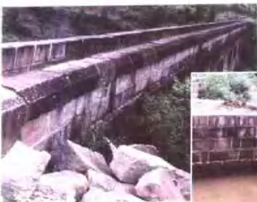
东干渠白埡子支渠渡槽
