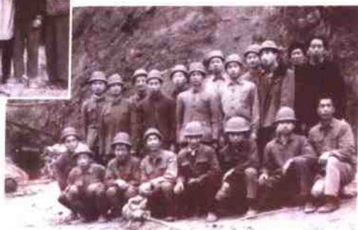
隧洞掘进连全体合影
