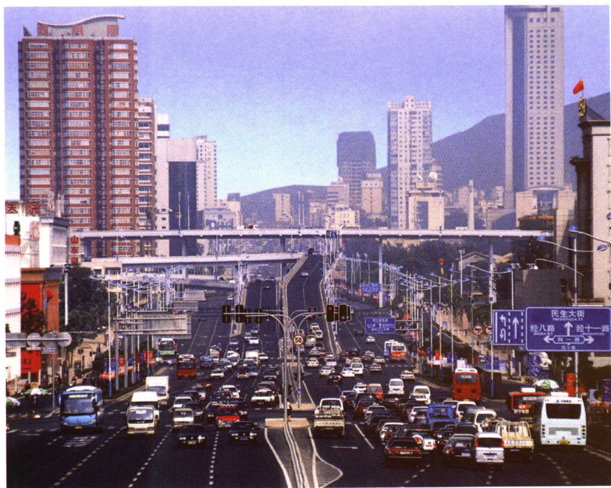
荣获“中国建筑工程鲁班奖”的 经十路道路及环境建设工程
