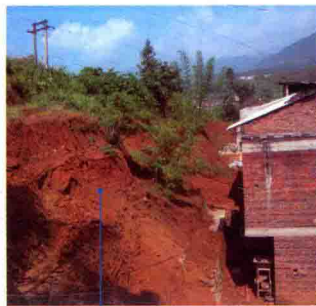
地层不稳定，植被稀少，容易引发地层垮塌、滑坡
