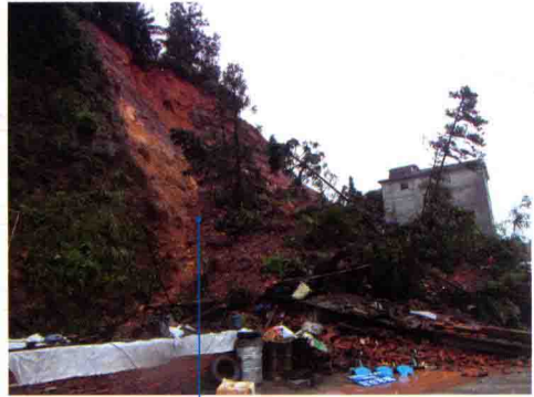
山体滑坡压塌房屋
