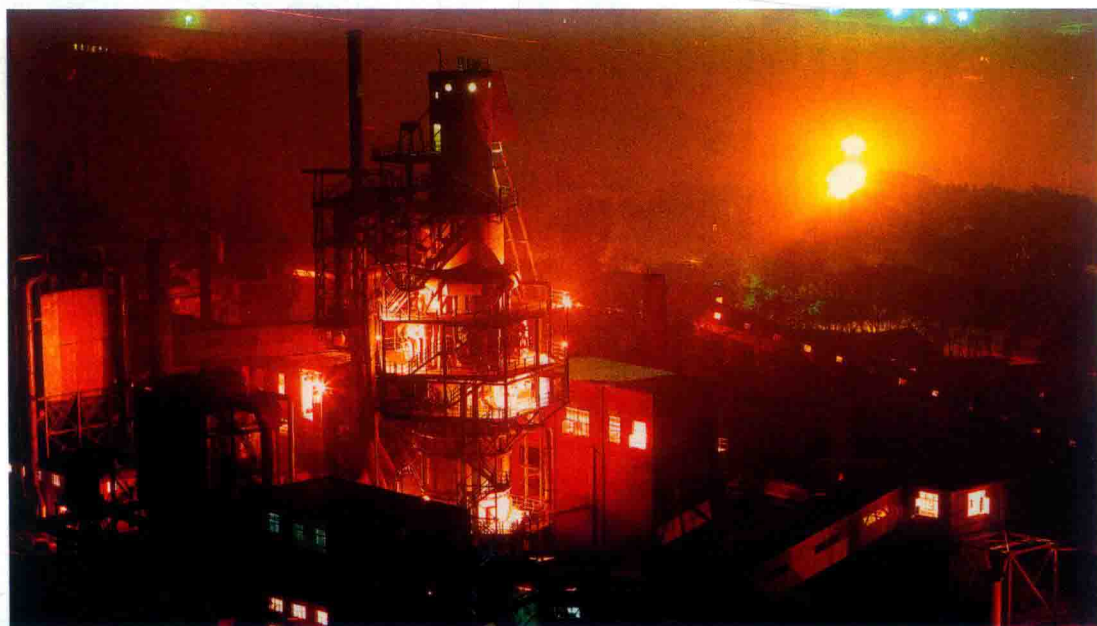
本钢石灰石矿竖窑
