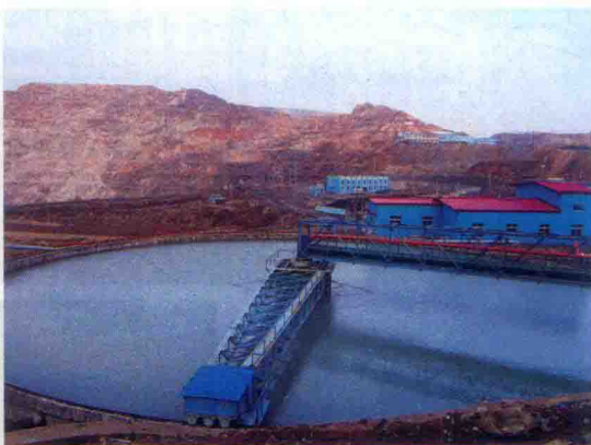
歪头山马耳岭选矿浓缩装置
