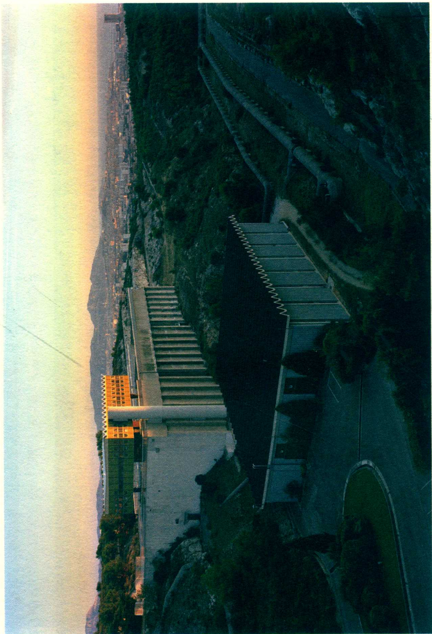
3. 北部街区。多尔山谷水库 (réserve d'eau du vallon Dol) 的饮用水处理厂 (水源地为韦尔东河, 通过普罗旺斯运河供水)。工厂、水库和运河建于 20 世纪 70 年代。
