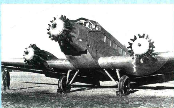
图 1-8 BMW 132 星型发动机应用在汉莎订购的 Ju52 飞机上
