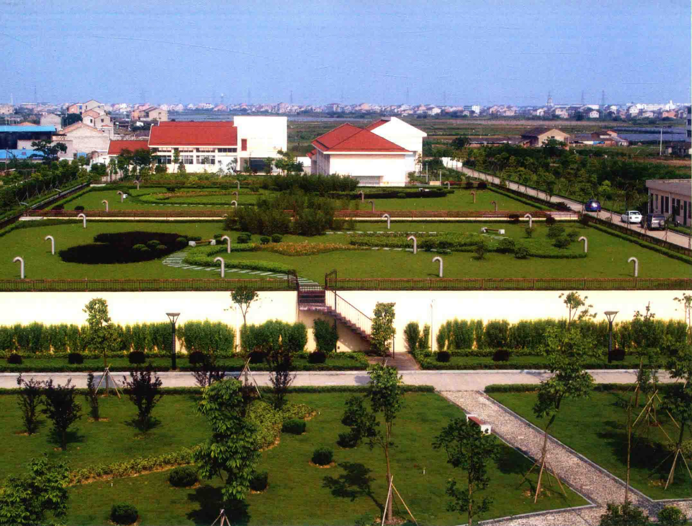
图1：椒南供水泵站。
