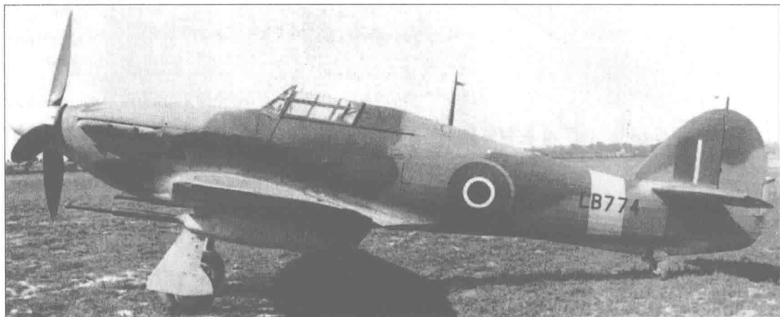
“飓风”的后期型号都用来执行对地攻击任务，因此用机炮替换了原来的机枪，并且在机翼下挂维克斯公司机炮吊舱来增强火力。
