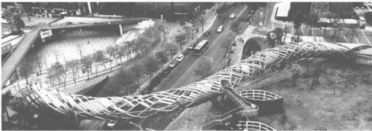
图 12 天桥外立面现场实景
