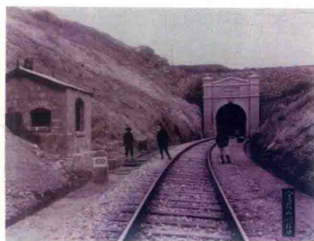
彩图十五 八达岭隧道北口 (王斌 提供)
