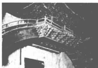
c 壁藏圈桥细部 d 壁藏细部 这是所见 最早的斜向华拱实例
