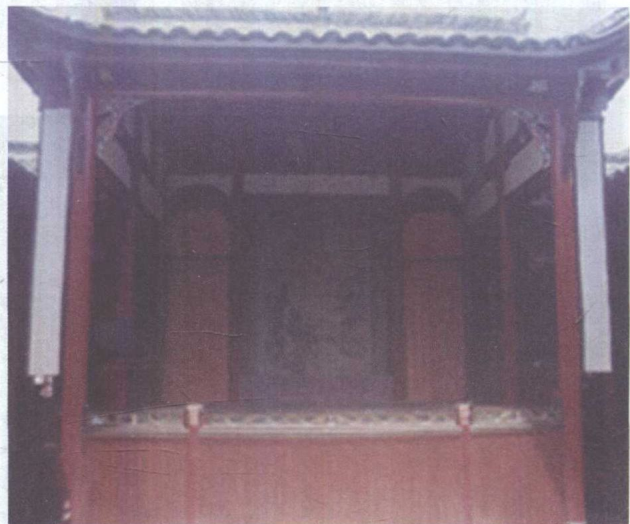
明末时期泰宁县城关李家宗祠维修后的古戏台
