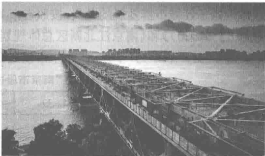
图3 维修中的南京长江大桥
