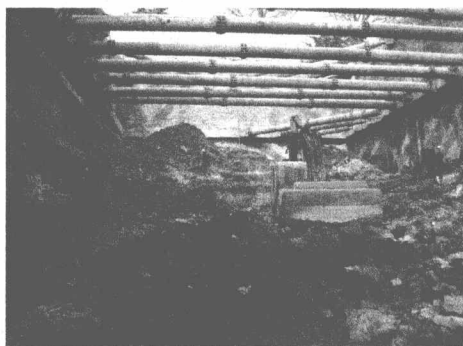
图 1.3 土岩组合地层基坑(青岛)
