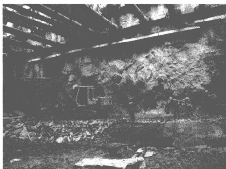
图 1.2 微风化花岗岩地层基坑(深圳)
