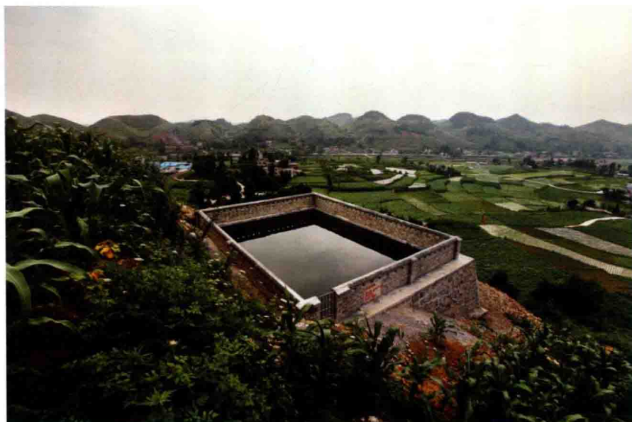
21世纪初期的烟水工程——山坡大型蓄水池
