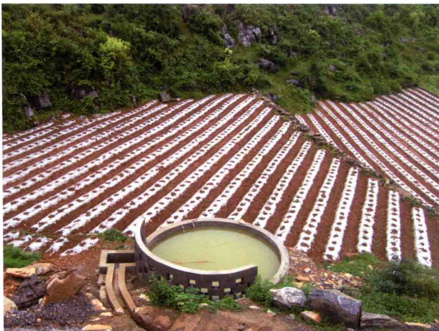
21世纪初期的烟水工程——集雨型小水池
