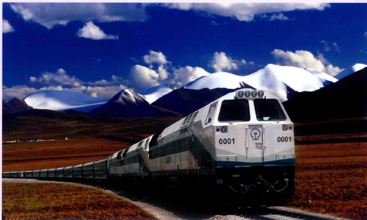
青藏铁路 全长1956千米，被誉为“天路”，是实施西部大开发战略的标志性工程、中国新世纪四大工程之一，也是世界上海拔最高、在冻土上路程最长、克服了世界级困难的高原铁路。
