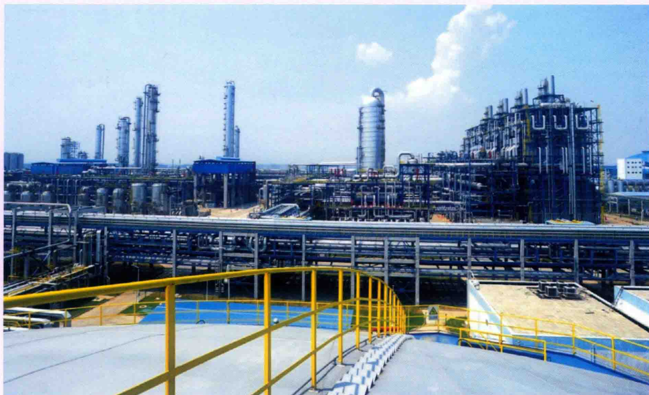
中国石油化工产业 大庆是中国重要的石化工业基地，具有千万吨的炼油、百万吨乙烯、百万吨丙烯加工能力，产业链延伸发展空间广阔。大庆高新区是全国唯一依托石油石化资源辟建的国家级高新区，为国家火炬计划石化产业基地，石化产业是接续产业发展的重要支撑。
