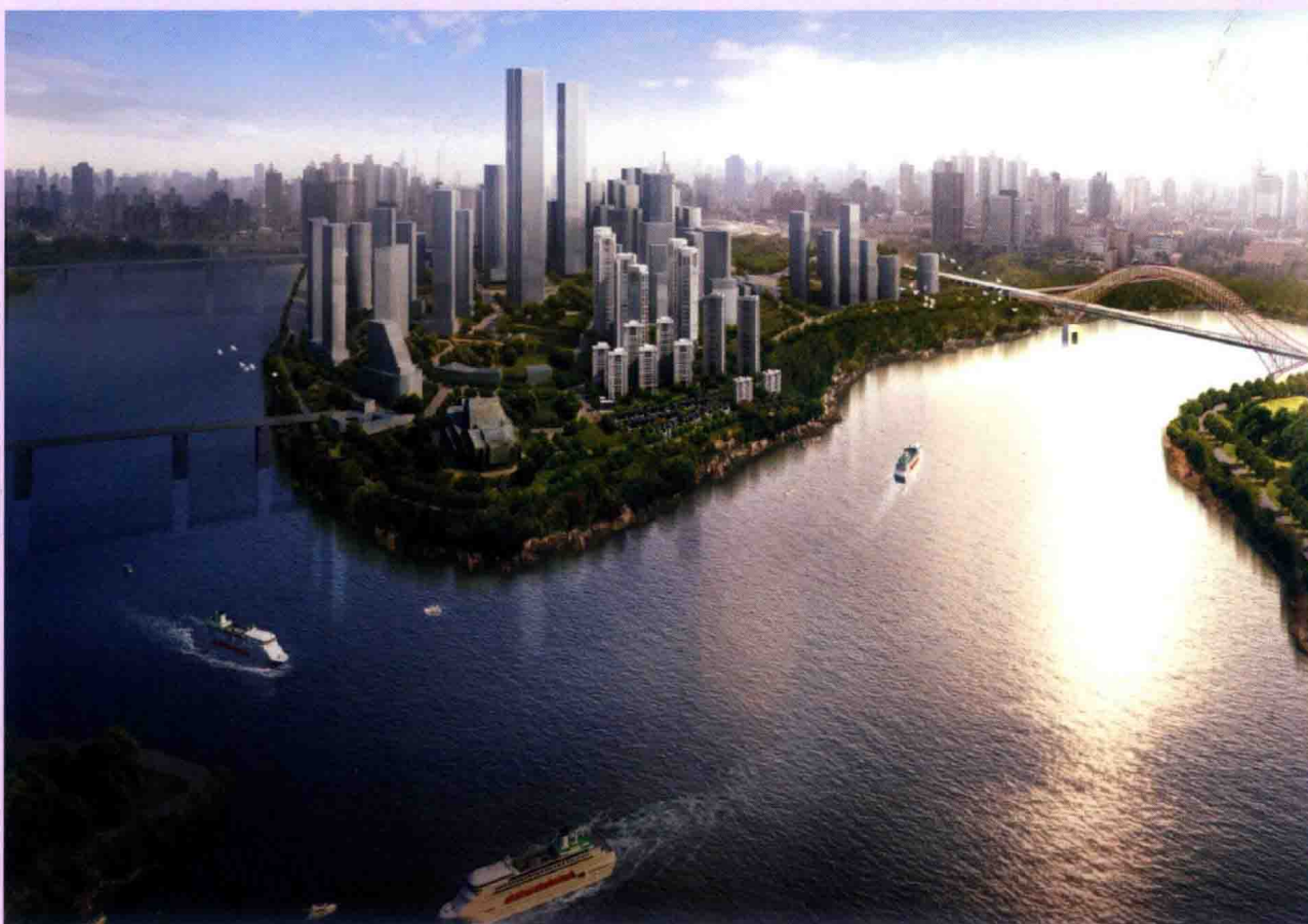
江北嘴中央商务区 位于重庆两江新区，是中国中西部地区唯一的国家级战略金融中心，是内陆地区对外开放的门户和窗口，和一江之隔的解放碑中央商务区共同承担中国中部地区及西部地区金融中心的职能。
