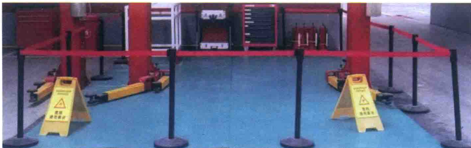
图 1-2 作业区域隔离与警示牌标示
