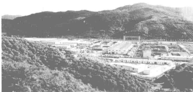
图 1-4 厂矿道路巡逻航拍图
