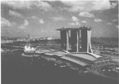
图 1-9 新加坡综合管廊（1）
