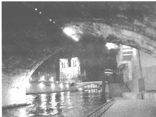
图 1-5 巴黎综合管廊（3） ( http://www.water8848.com/news/201609/22/78386.html )
