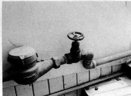
(2) 严格按阀门安装说明书进行安装，明杆闸阀留足阀杆伸长开启高度，蝶阀充分考虑手柄转动空间，各种阀门杆不能低于水平位置，更不能向下。暗装阀门不但要设置满足阀门开闭需要的检查门，同时阀杆应朝向检查门。
