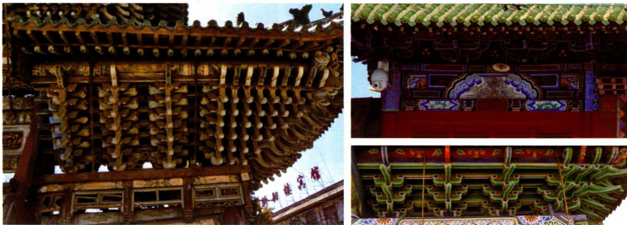
原小召寺牌楼之斗拱(左) 席力图召门楼之斗拱(右上) 苏里格庙牌楼之斗拱(右下)
