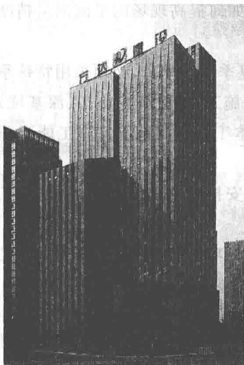
图 1-1 工程现状情况
