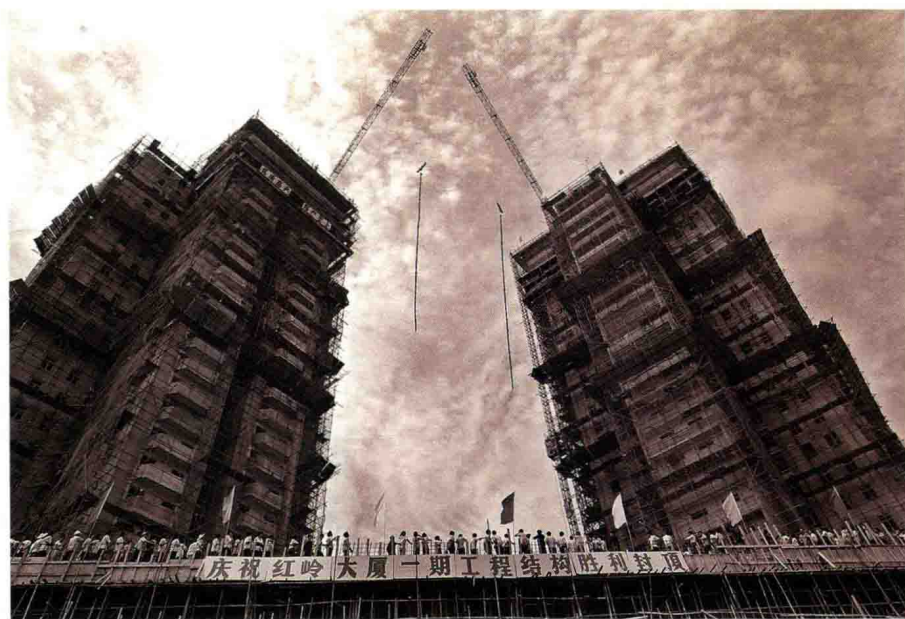
红岭大厦主体封顶 周顺斌/摄影
