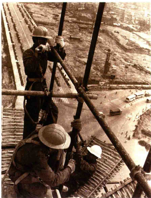
1983年10月，深南中路与红岭路交叉口的红岭大厦施工现场。施工的是基建工程兵改编的市建筑公司 杨洪祥/摄影
