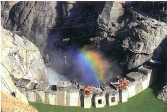
图 1-8 拉西瓦水电站地理位置及外貌
