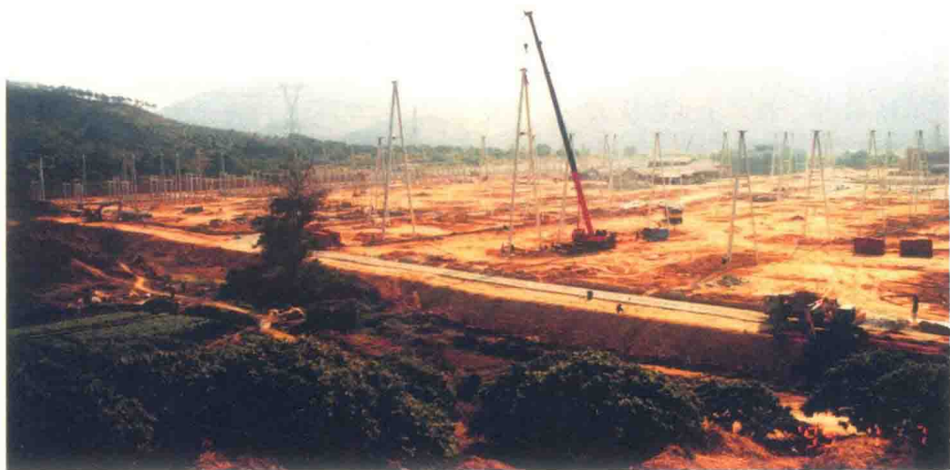
1998年，东莞首座500千伏超高压枢纽变电站——500千伏东莞变电站土建施工
