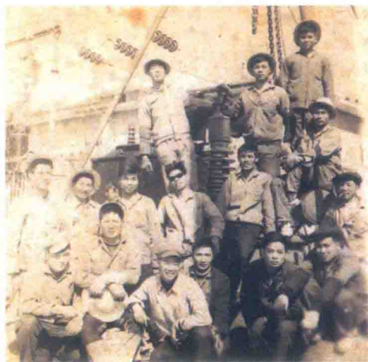
1965 年，东莞县供电公司高压班在 35 千伏寮步变电站进行 4000 千伏安变压器吊芯
