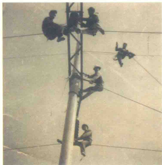
1970年，东莞县供电公司施工班在企石东山村110千伏惠峡线施工
