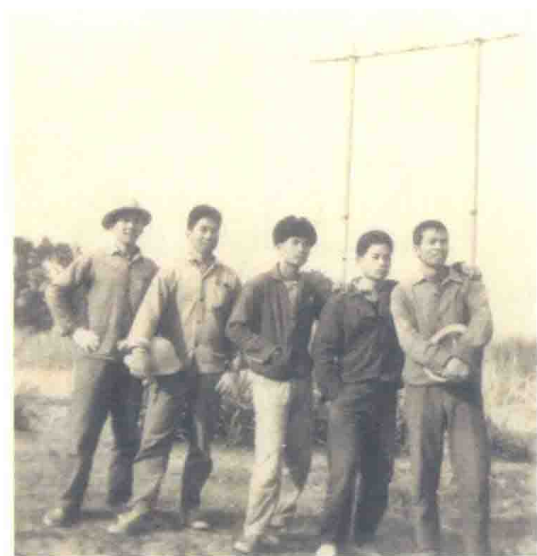
1969年，东莞县供电公司员工在石龙燕窝村进行35千伏峡岩线施工
