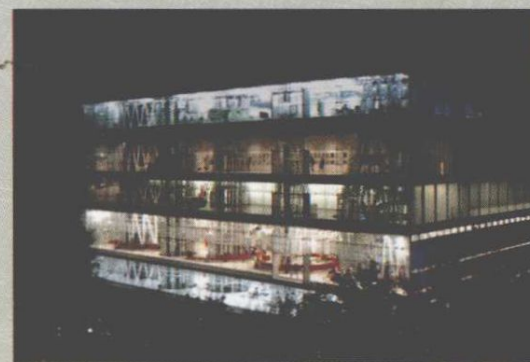
仙台媒体中心, 伊东丰雄, 宫城县, 2001年 Sendai Mediatheque by Toyo Ito, Miyagi, 2001
