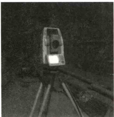
图 1-1 隧道工程测量
