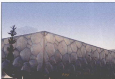
晶体艺术之美多面体空间刚架结构
