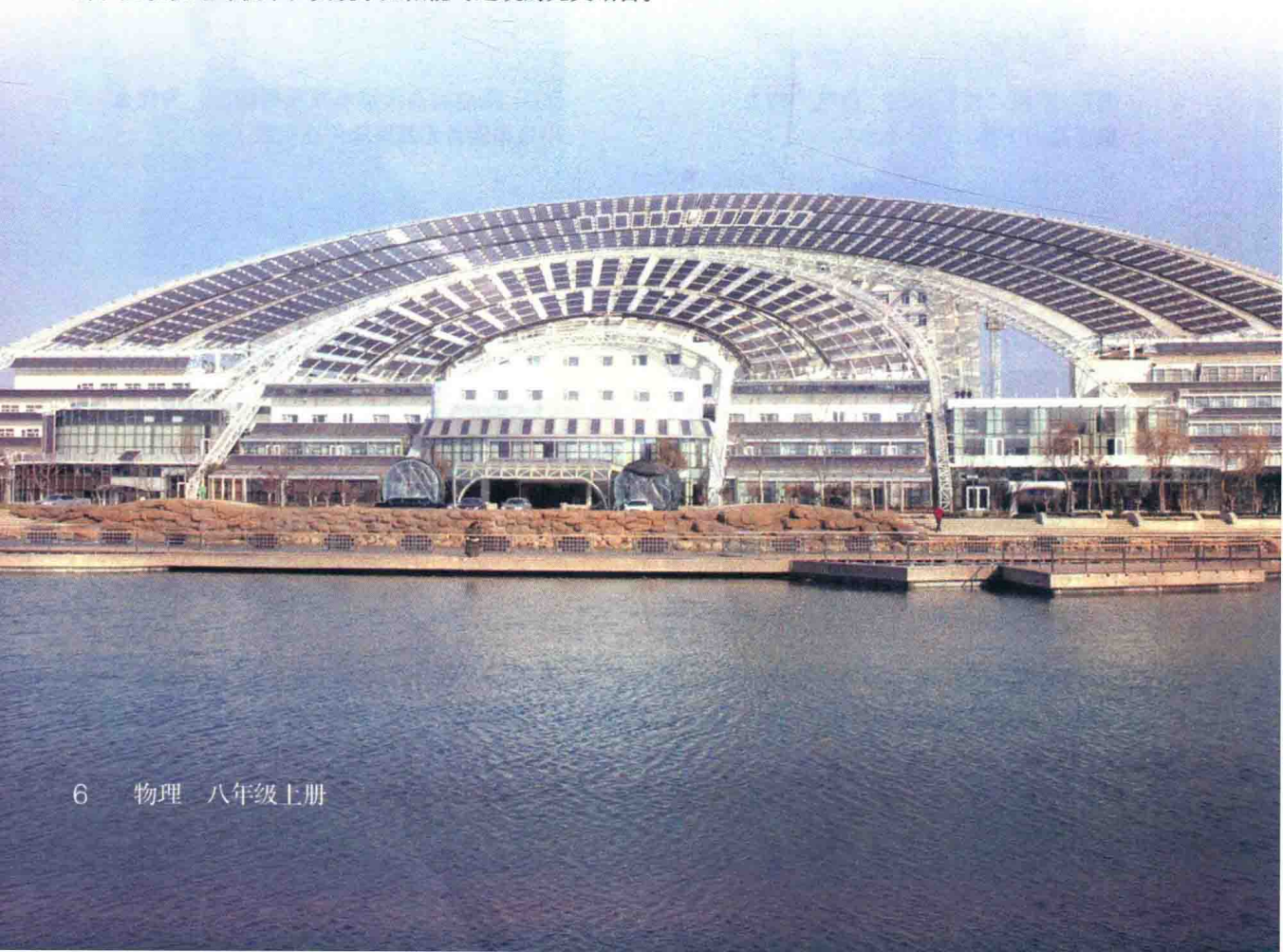
图11 绿色节能的太阳能建筑——现代社会对能源的需求越来越多，而煤炭和石油等不可再生能源越用越少。太阳能可以说取之不尽，而且是清洁能源。太阳能建筑综合运用了太阳能热水供应、采暖、制冷、光伏发电等技术，实现了太阳能与建筑的完美结合。
