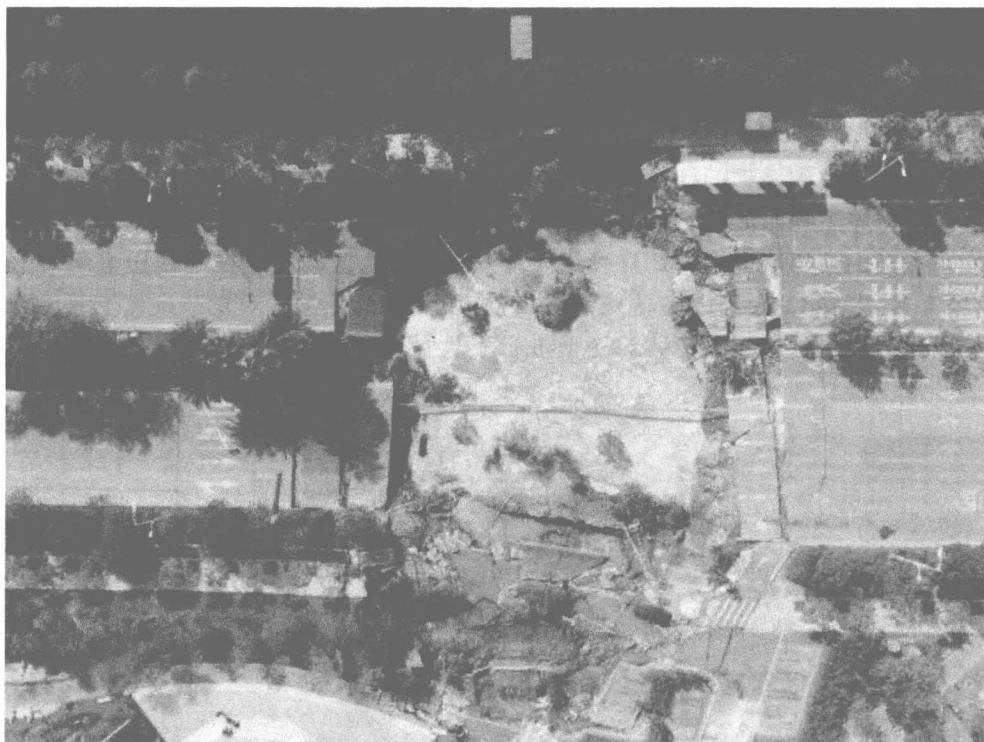
图 0-4 佛山地铁事故现场
