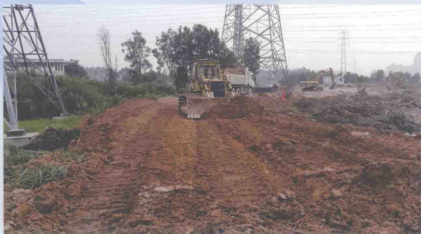
施工前的茅洲河 1号底泥处理厂
