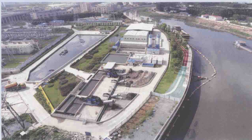
茅洲河 1 号底 泥处理厂新貌
