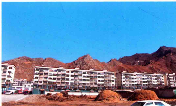
藏热村辖区内正在新建的城关区廉租房
