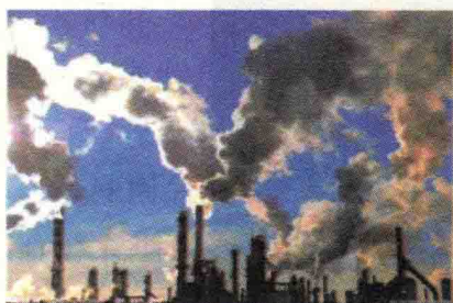
燃料燃烧排放的烟气
