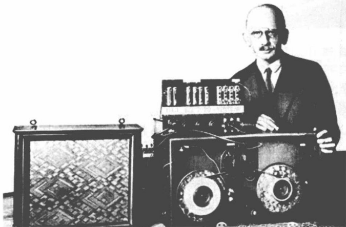
图 0-11 德国科学家弗里茨·波弗劳姆和他发明的纸质磁带录音机
