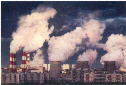
图 1-27 火力发电设备
