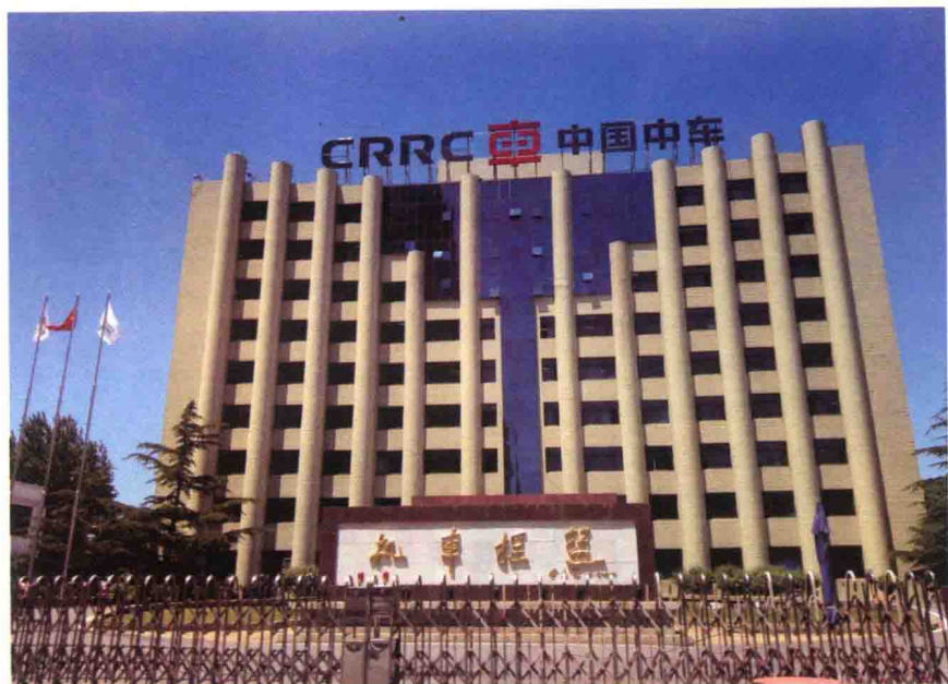
照片 12：沙河口铁道工厂 1949 年后改组为大连机车厂，作者摄于 2017 年 5 月
