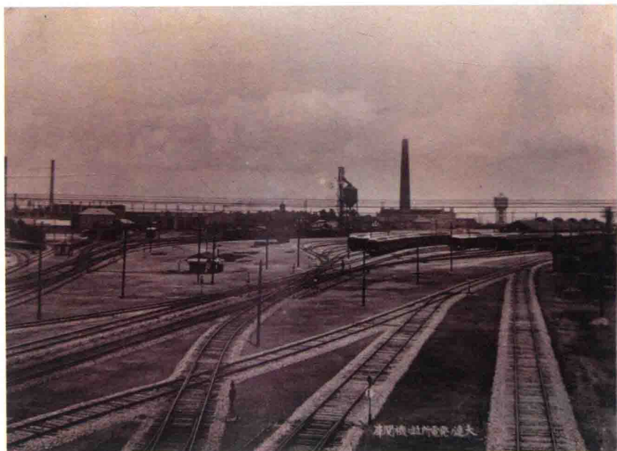
照片 13：伪满时期大连工业景观，作者收藏旧照片
