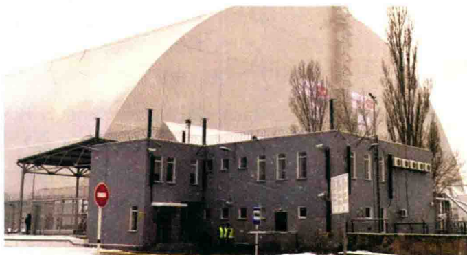
图 3 在乌克兰的切尔诺贝利，实体的、安全的圆顶房屋滑动到严重受损的反应堆之上
