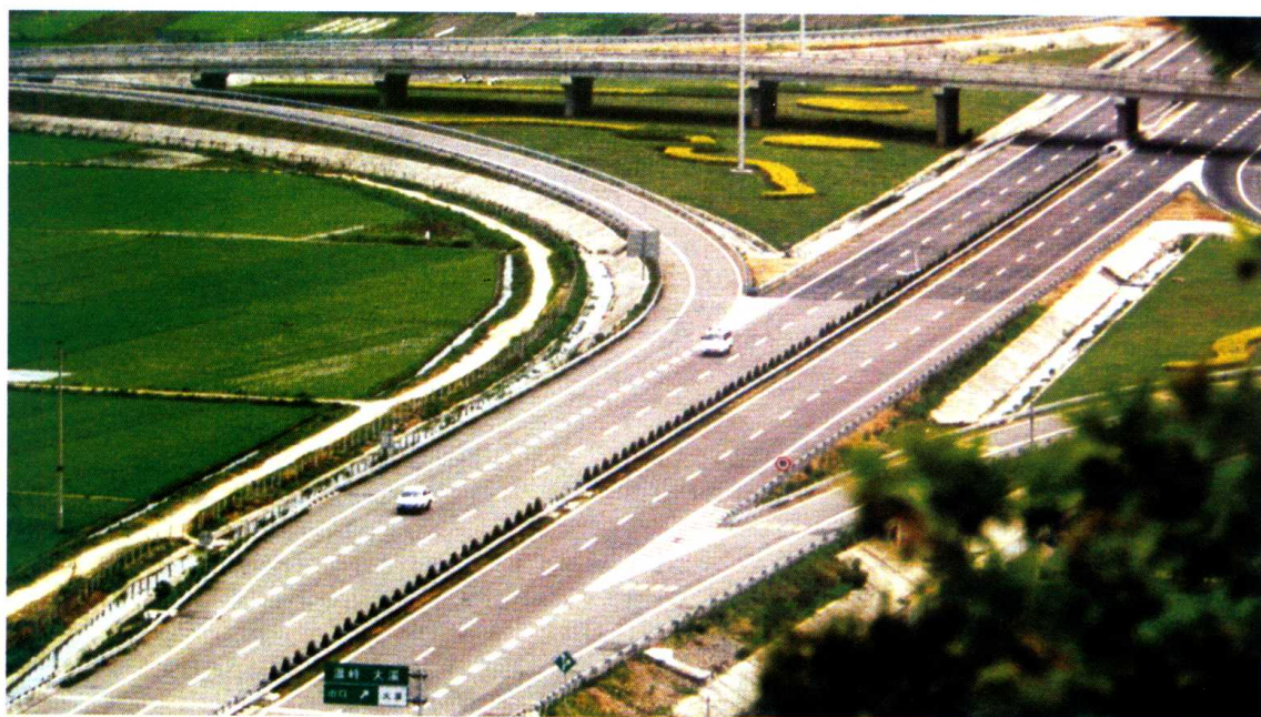
甬台温高速公路大溪出口
