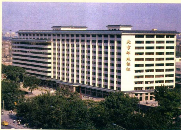
北京市邮政管理局办公大楼。
