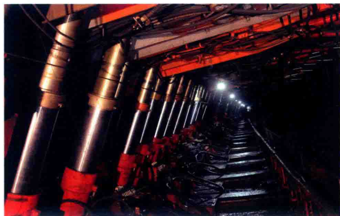
2008年5月，水城矿业（集团）所属煤矿井下综采工作面
