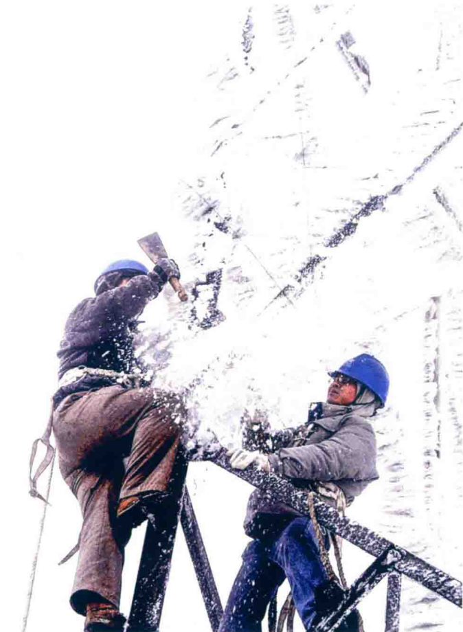
2008年1月16日，安顺供电局员工冒着严寒在110千伏中纳线54号铁塔上除冰
