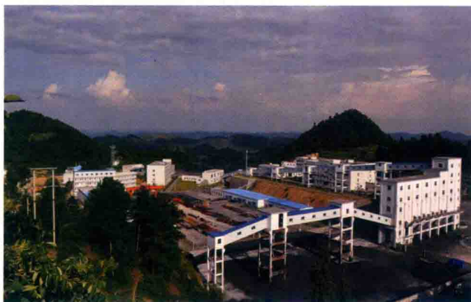
2009年，永贵能源高山煤矿矿貌图
