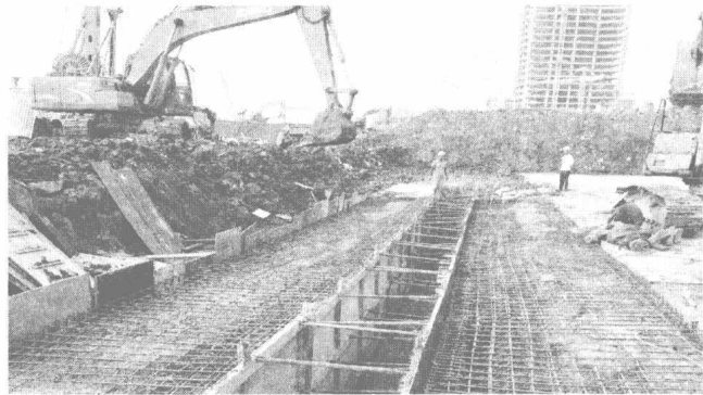
图 1-6 浇筑导墙混凝土
