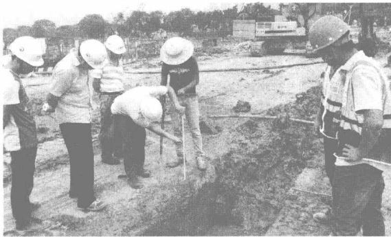
图 1-11 槽段检验
