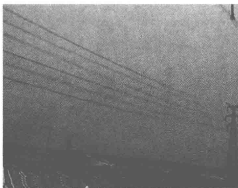
b) 某高压输电线路导线舞动现场的视频截图：未舞动(左图)发生舞动(右图)
