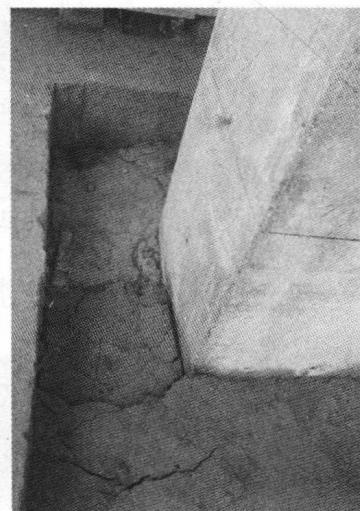
**错误：**土方回填不及时，导致基础长期被雨水浸泡；土方回填不到位，导致基础积水。
