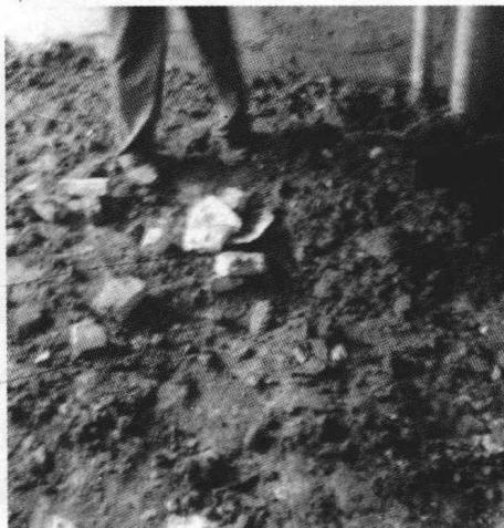
**错误：**回填土的质量太差，有的甚至回填土埋的全是垃圾，如此施工容易造成土方下沉，拉裂地面。
