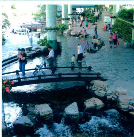
2011年东濠涌综合整治一期工程完工。
